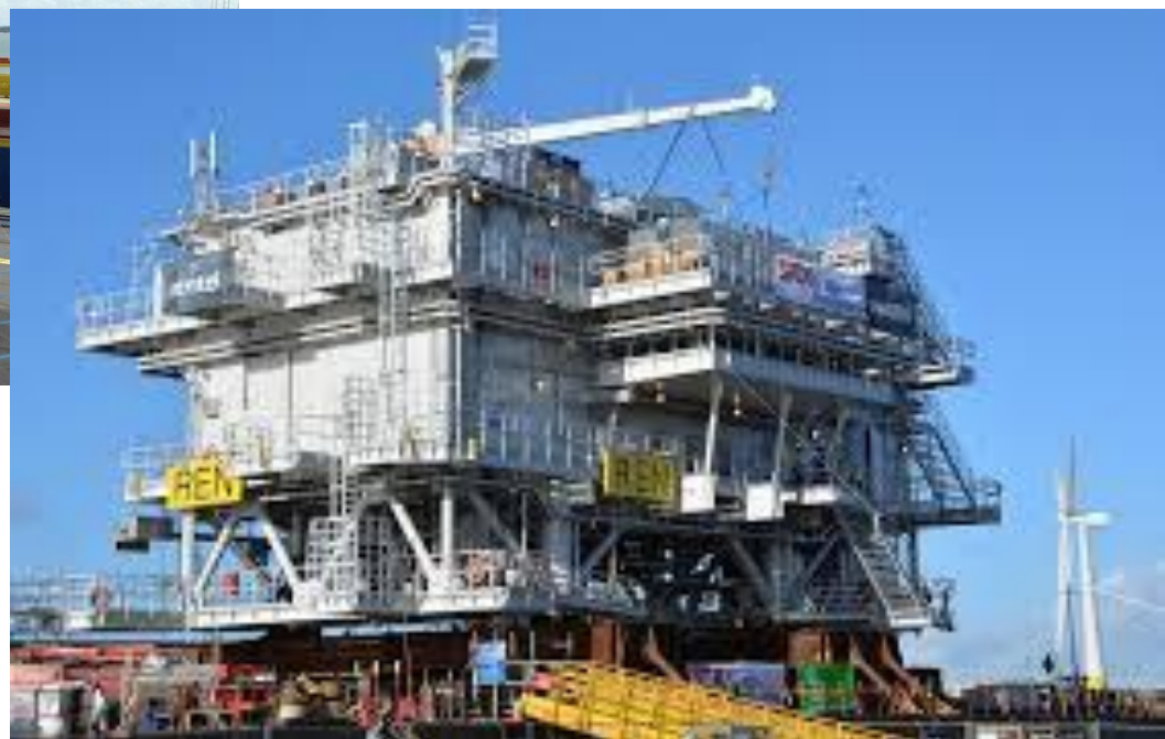
Source Chantiers de l'Atlantique (Sous-station électrique)
